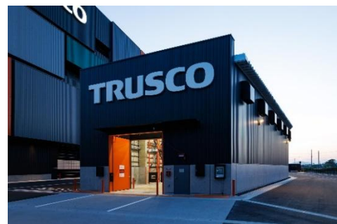
安全・安心な保管で安定供給を支える危険物倉庫 (最大 488 パレット収納可能)
