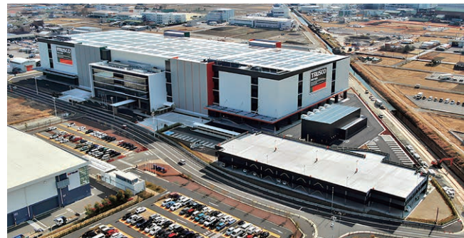
プラネット愛知建設状況(撮影日: 2025年1月)
