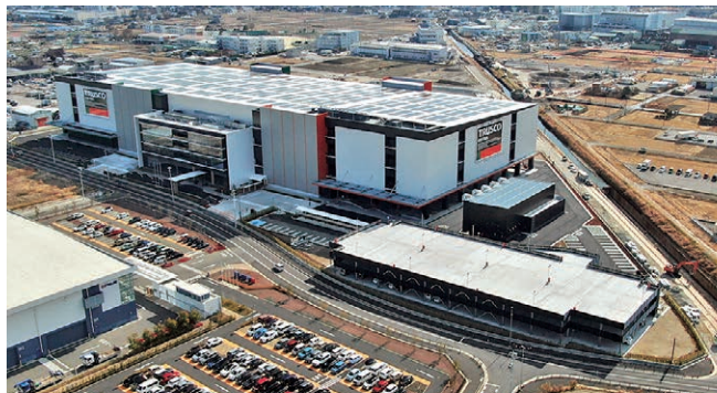
プラネット愛知建設状況(撮影日:2025年1月)
