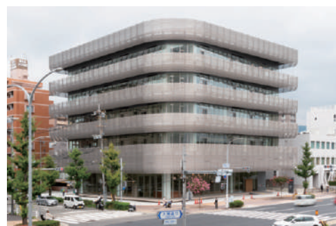
新中山記念会館（令和3年（2021）9月15日竣工） 敷地面積：424坪 延床面積：1,728坪 建物構造：地下1階、地上5階、柱頭免震
