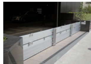
東京本社 浸水対策「止水板」
