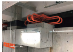
プラネット南関東 免震装置
