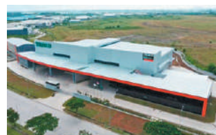
敷地面積4,894坪、延床面積3,155坪
