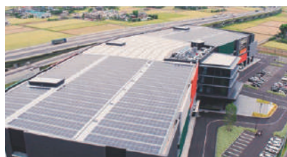
プラネット埼玉屋上の太陽光パネル
