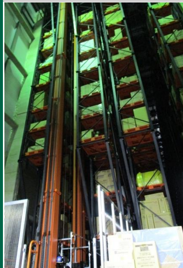
↑プラネット北関東自動倉庫内
