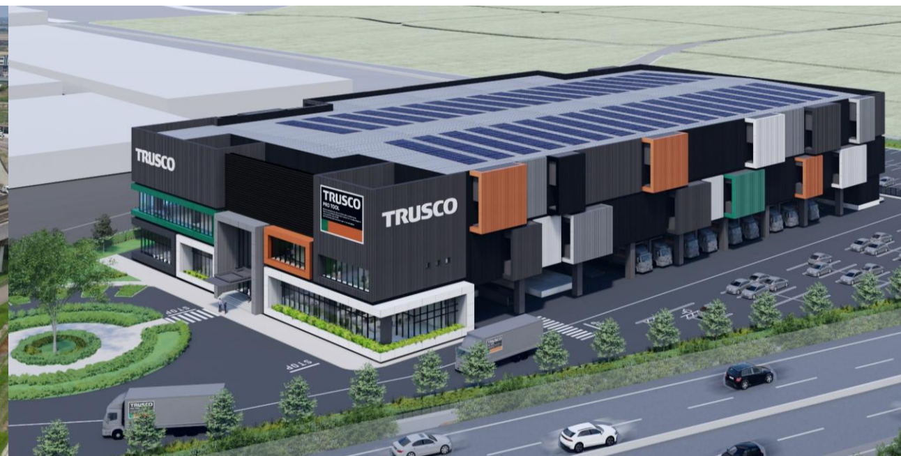
プラネット長野 延床面積6,156坪(20,350㎡) 2029年6月末建屋竣工予定
