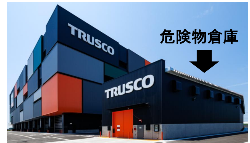
HC東日本物流センターの危険物倉庫
