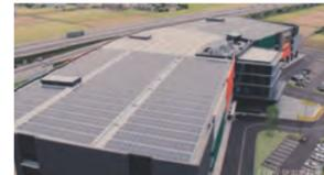
プラネット埼玉屋上の太陽光パネル(750kW)。2026年稼働予定のプラネット愛知屋上には1,867kWの太陽光パネルを設置予定です。
