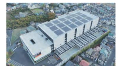
プラネット南関東の太陽光発電設備(発電能力 300kW) (パネル枚数 1,190枚)
